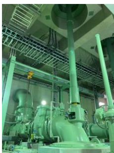
沈砂池ポンプ棟
