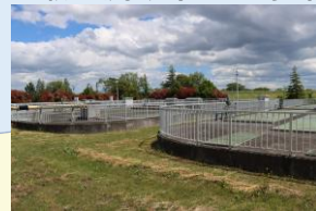
鹿島台浄化センター
